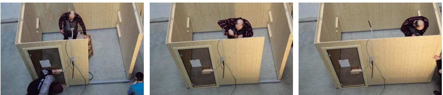
**8** Para que los paneles se ajusten herméticamente entre sí, use una pequeña barra de madera, que coloca en el ángulo entre el marco base y el panel que necesita reparar. Al golpear suavemente con un martillo de goma, este panel se ajustará perfectamente al panel previamente instalado. (Imágenes arriba)
