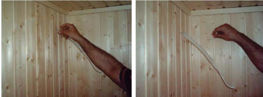
**16\*** Los cables ya están colocados en el panel. Realice las conexiones al panel digital e instalelo. Las conexiones de los cables se muestran en el manual de adjunto de acoplamientos. \* Solo si el calentador es con unidad de control externa.
