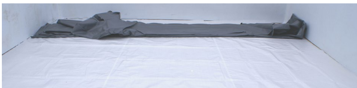
Figura 32 – Despliegue del liner
