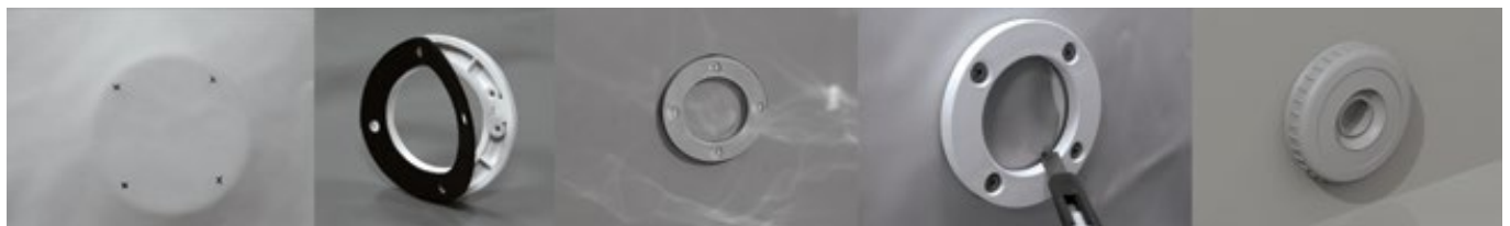
Figura 34 – Montaje de la brida sobre el retorno
