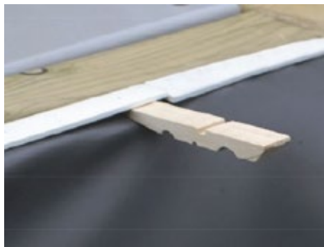
Figura 31 – Bloqueo del liner con pinzas de la ropa
