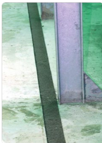
Figura 8 – Instalación de tiras bituminosas
