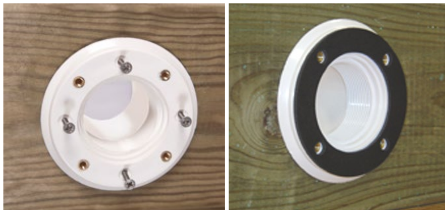
Figura 23 – Montaje del cuerpo de la boquilla de retorno y su junta
