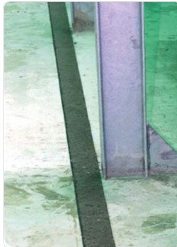
Figure 9 – Mise en place des bandes bitumeuses
